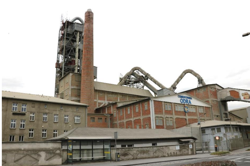
Źródło: fot. I. Solisz. Ryc. 15. Cementownia Odra
