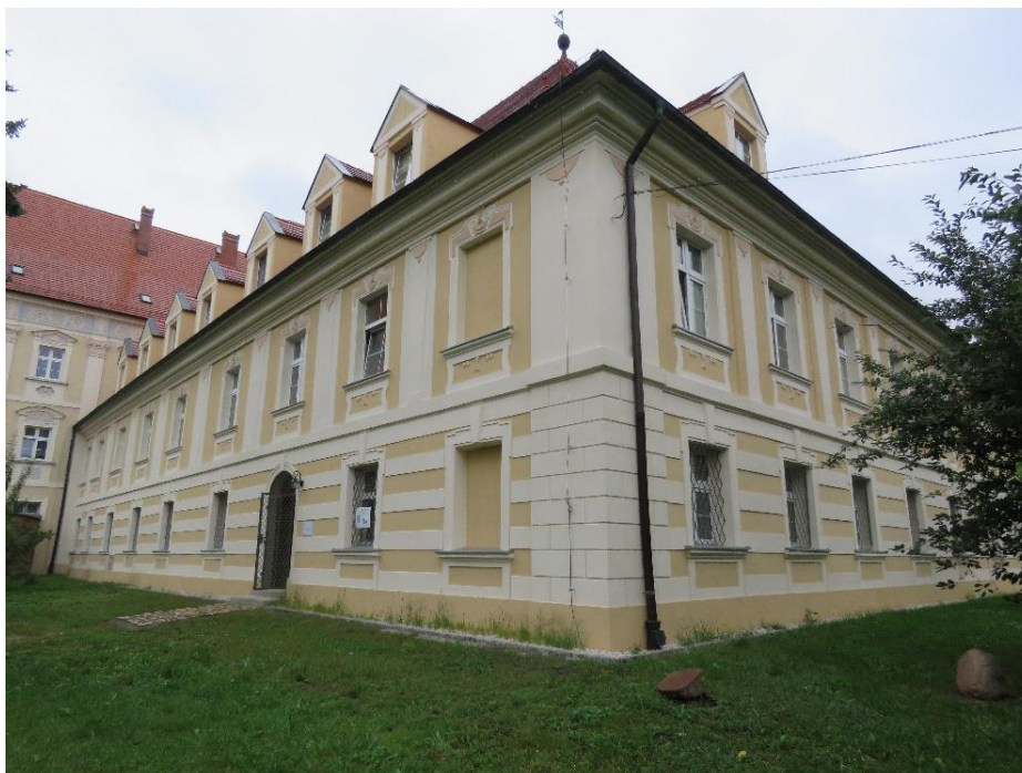
8. Budynek prałatury w klasztorze po wykonanych pracach remontowych, fot. I. Solisz
