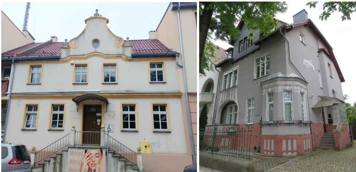
10. Kamienica ul. Malczewskiego 4, 11. Willa ul. Niedziałkowskiego 16, fot. I. Solisz
