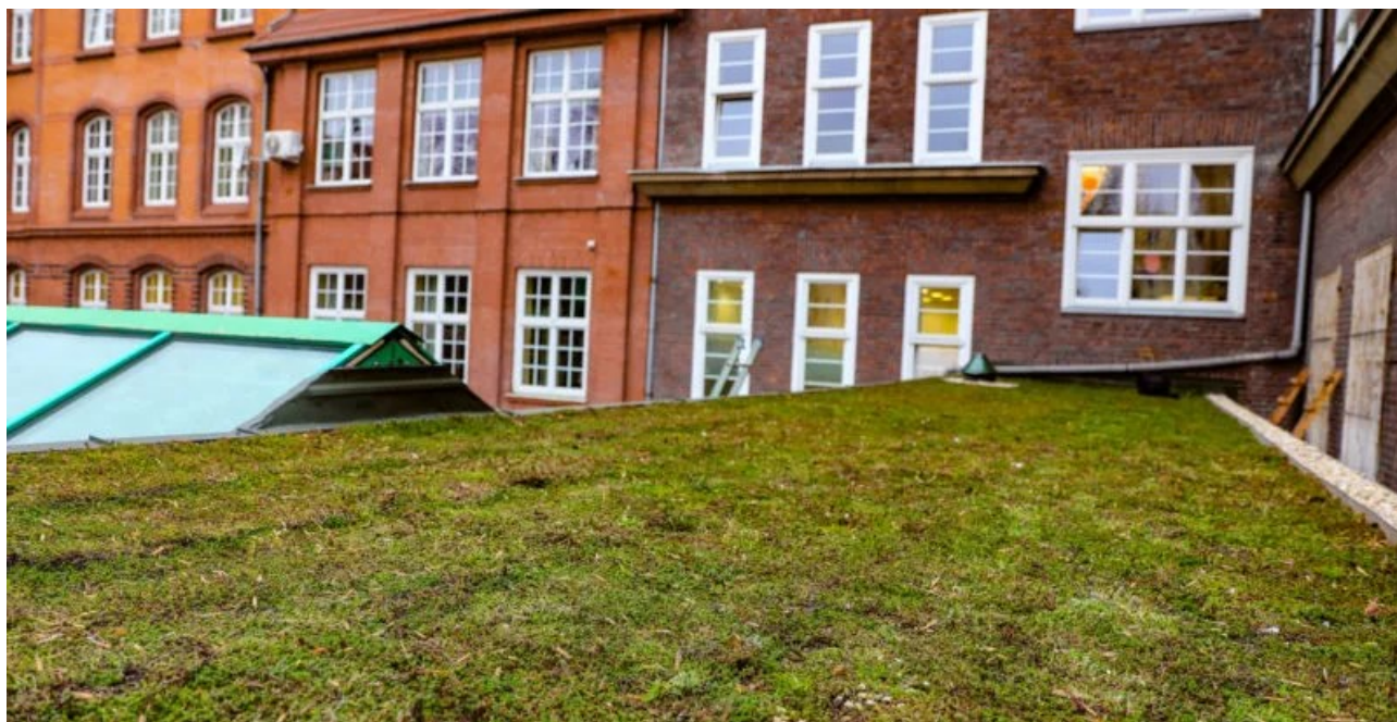
Zdjęcie 5 Zielony dach Publicznego Liceum Ogólnokształcące nr 5 14
